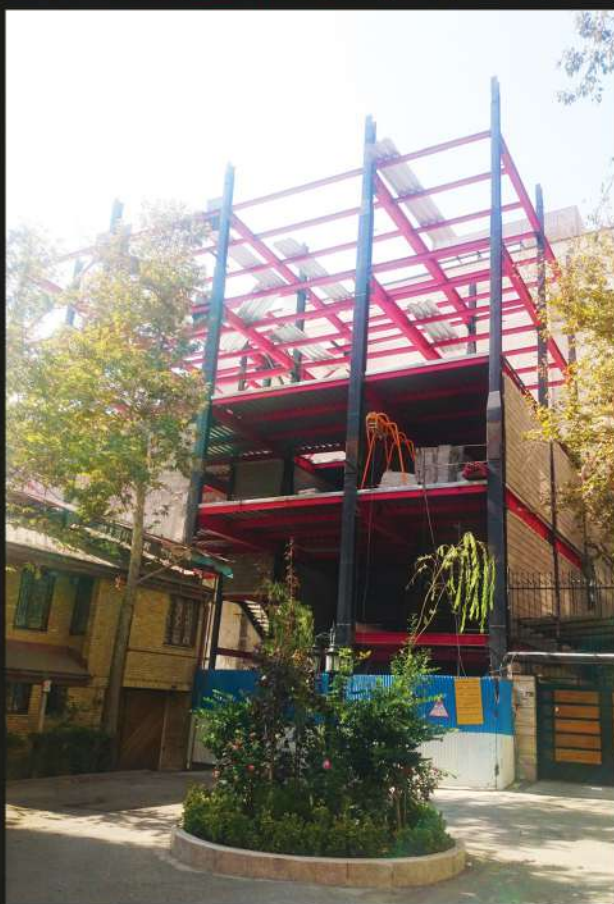
پروژه فرمانیه (خیابان سعیدی) اتصال جوشی WFP ۲۷۰ تن
