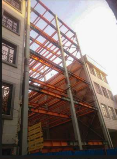
پروژه فاطمی اتصالات: WUF-W, BFP ۱۲۰ تن
