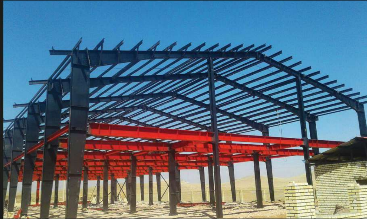
پروژه کارخانه آرتیمان اتصال جوشی ۱۰۰ تن
