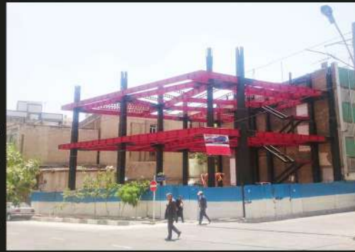
▶ پروژه هفت تیر (خیابان نوری اسفندیاری) اتصال پیچ و مهره WUF-W,BFP
