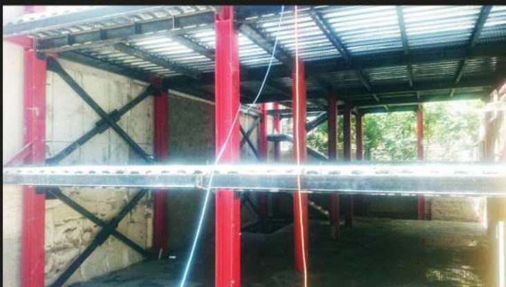
پروژۀ کوروش (خیابان شریعتی) اتصال پیچ و مهره WUF-W,BFP ۲۷۰ تن
