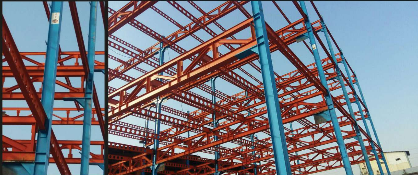
پروژه کارخانه کفش شوپا اتصال جوشی ۱۲۰ تن
