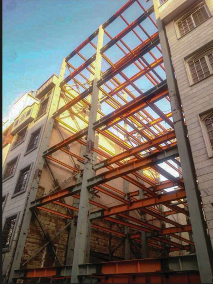
پروژه فاطمی اتصالات: WUF-W, BFP ۱۲۰ تن
