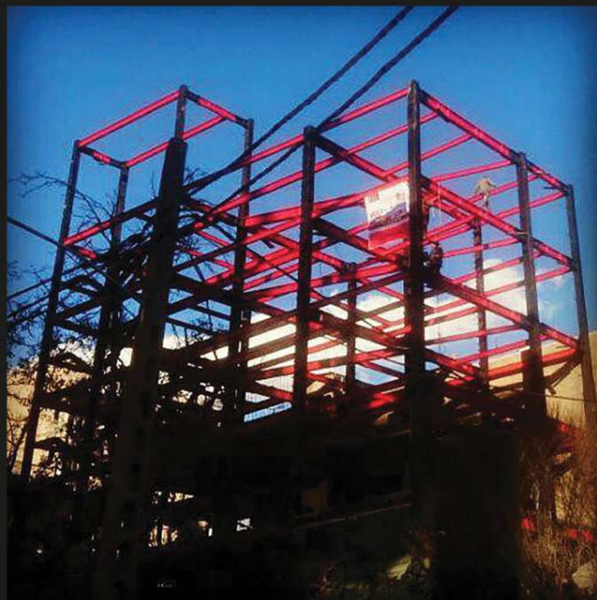
پروژۀ اندرزگو (خیابان شریفی منش) اتصال پیچ و مهره WUF-W,BFP ۱۸۰ تن
